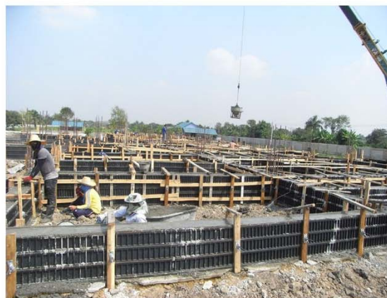
เปลี่ยนมาใช้สปริงคลิบช่วยให้ง่ายกว่าเดิม
